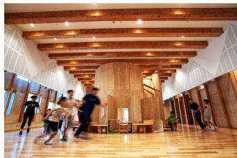
福祉型障がい児入所施設としては、全国初の「全面木造軸組+全面木質空間」である。一般的な在来工法と流通材の小径木の活用を徹底し、11mスパンのプレイホールにおいても小径木と構造用合板からなる合成梁とし、コスト縮減に努めている。平面計画は従来のサテライト式ではなく小規模なユニットが雁行する回遊性を重視したプランとなっており、要所に子どもたちの居場所となるニッチなスペースが設けられている。ホール中央にはオランダの「スヌーズレン」から着想を得た
