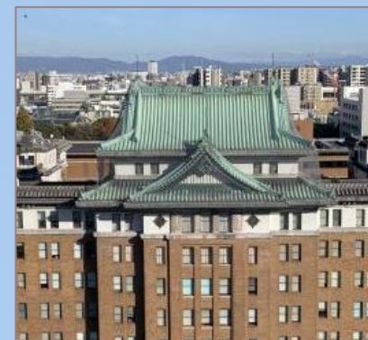
改修前の本庁舎屋根
