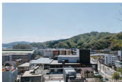
釜石市民ホール
