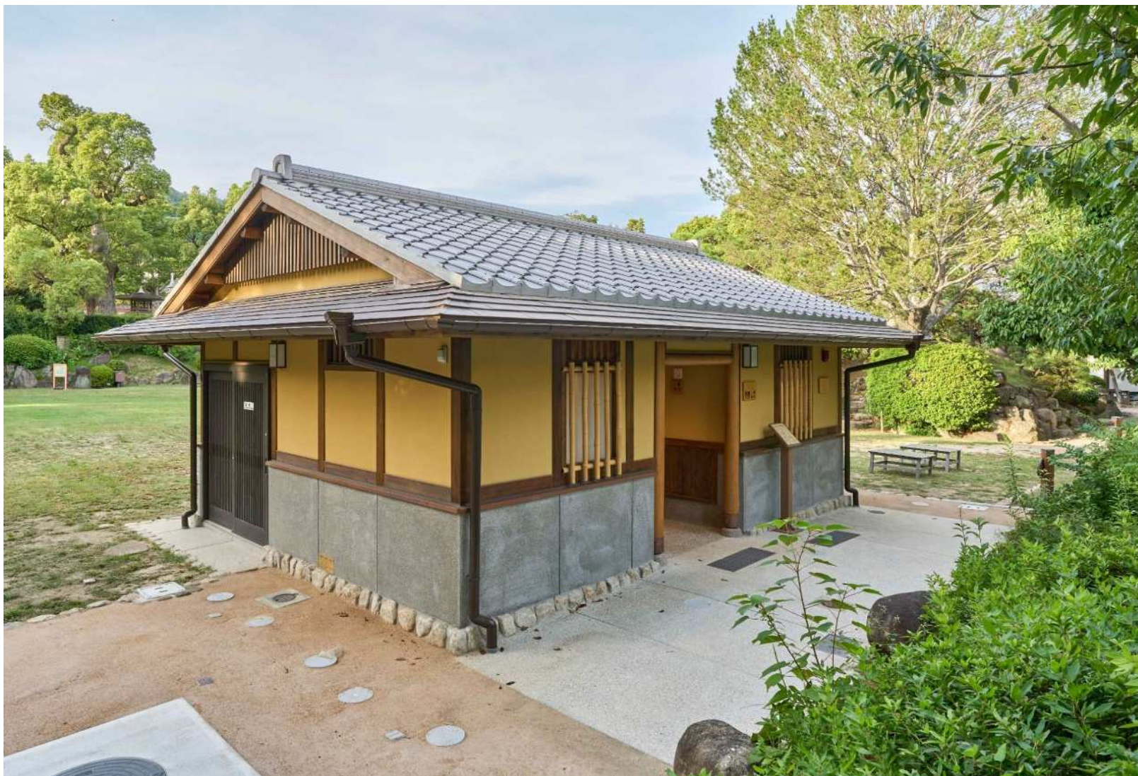
▲外観（トイレ側）
