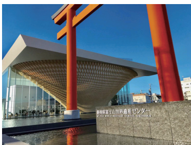
建物：富士山世界遺産センター 完成年・場所：H29・富士宮市 構造：鉄骨造 地上5階建
