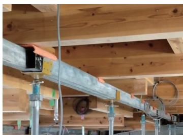
足場の上に梁を受ける仮設土台(支保工)を設置します。
