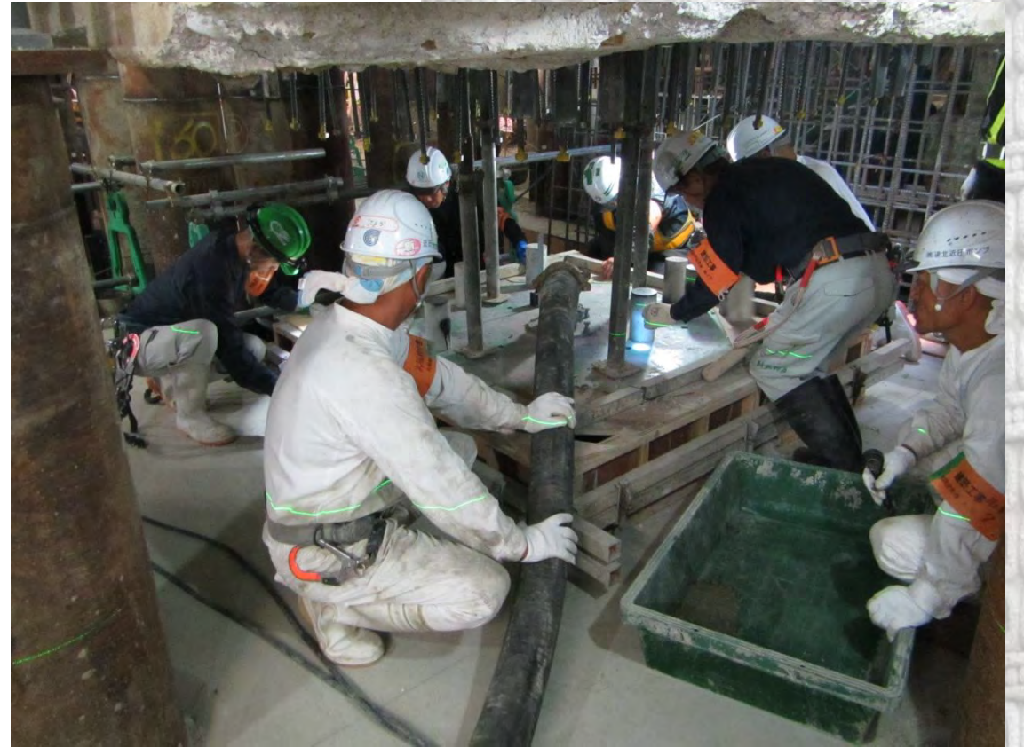
積層ゴム支承 下部基礎 コンクリート打設状況
