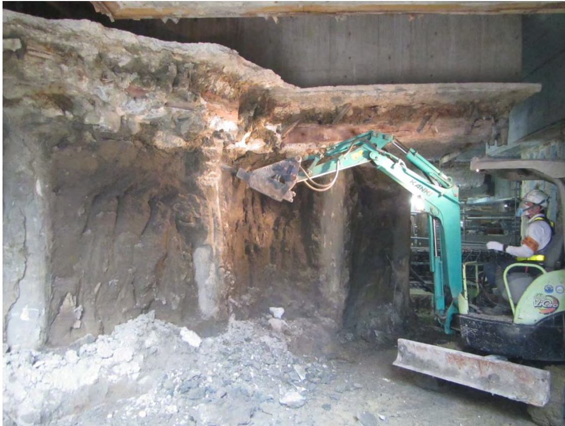
3次4次掘削（既設基礎下掘削）状況
