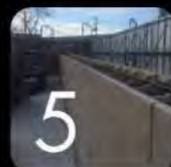
5 型枠不要のため約8,000㎡の型枠資材を節約
