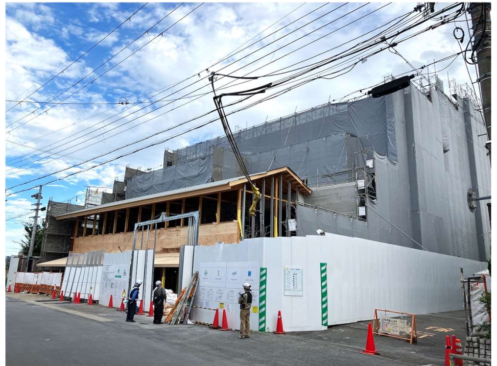
内外装施工中
