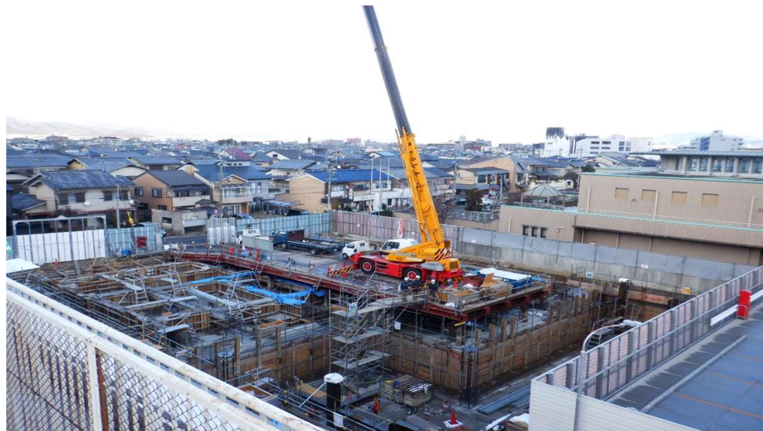
地下躯体施工中
