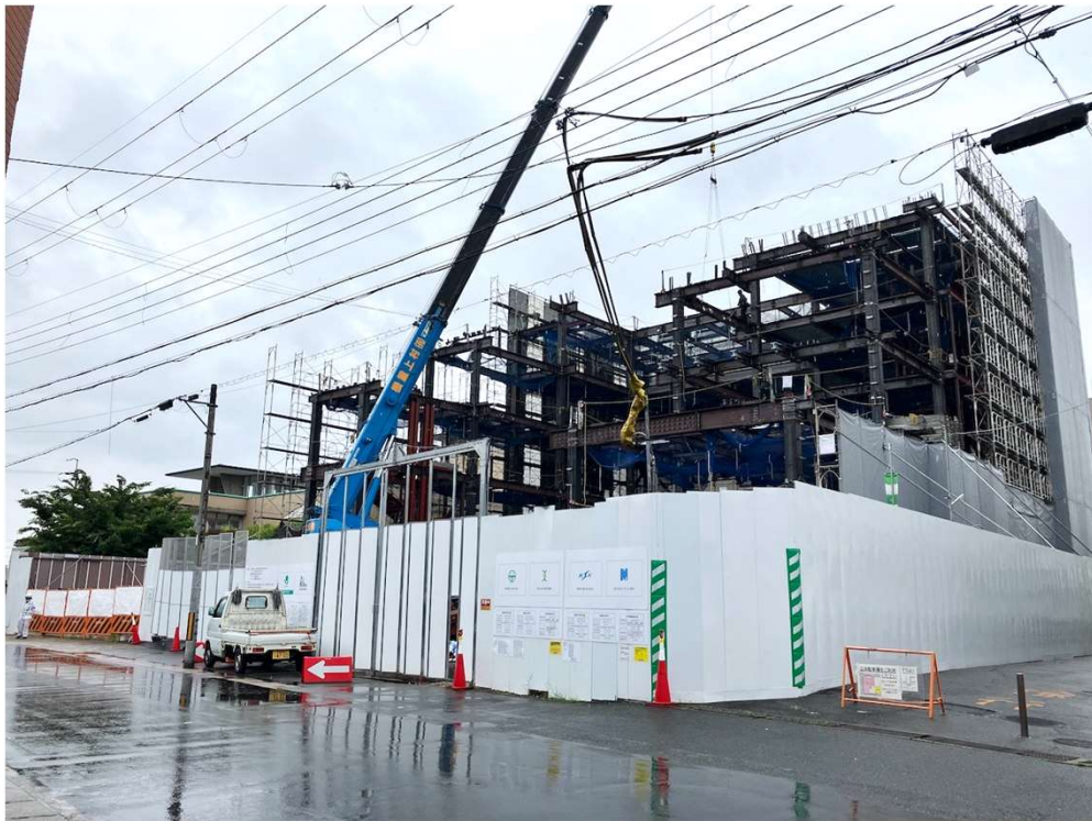
鉄骨建て方中
