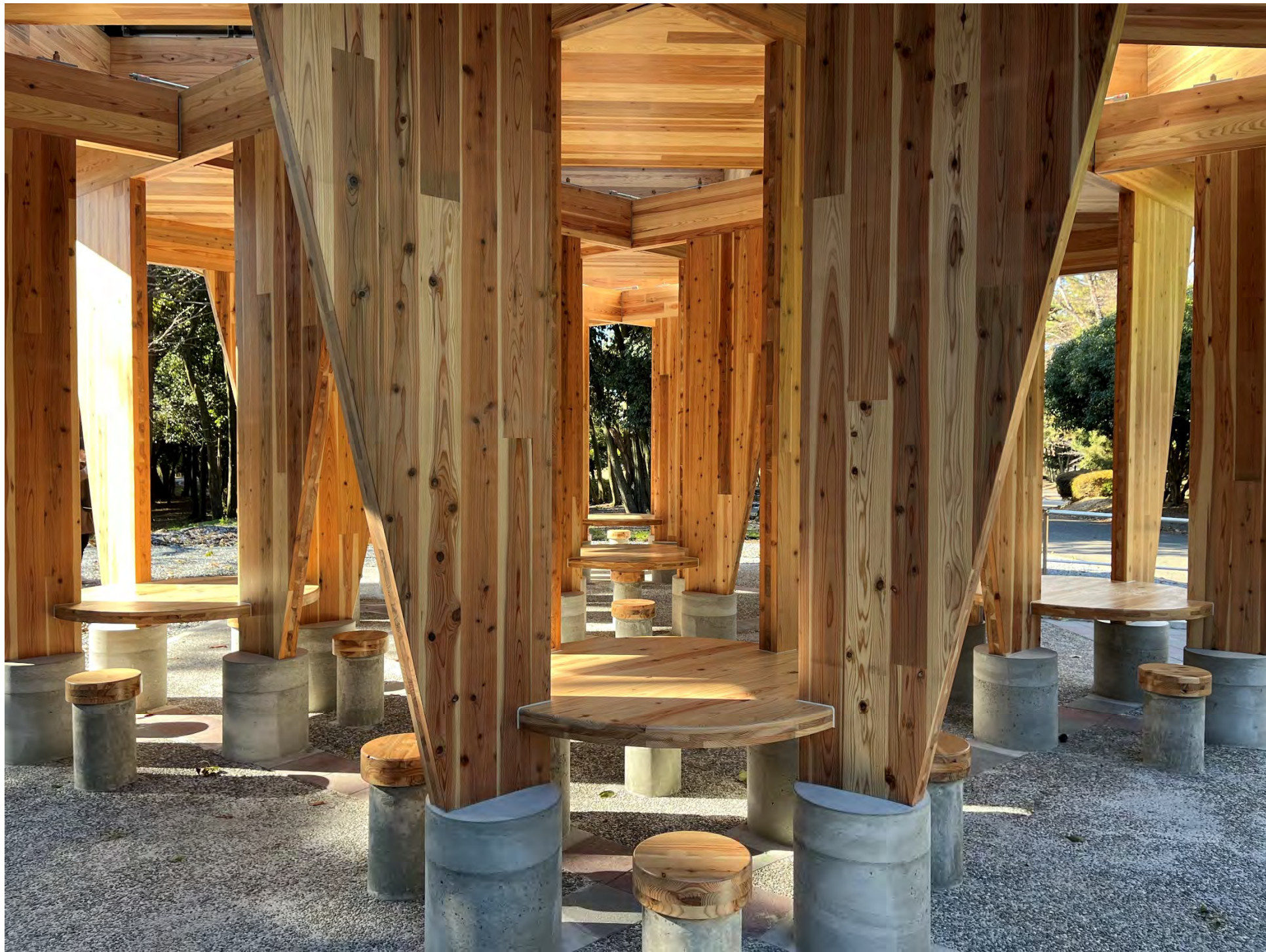
休憩スペース
