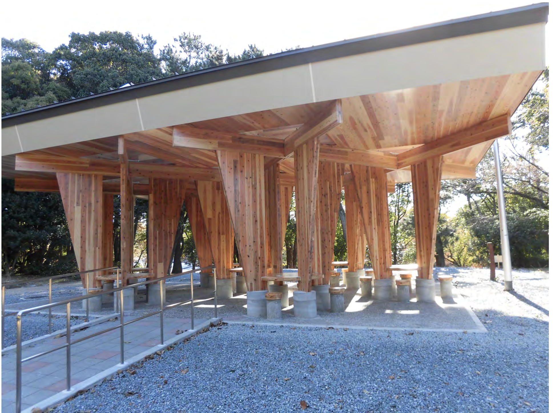
休憩所 正面（北側）
