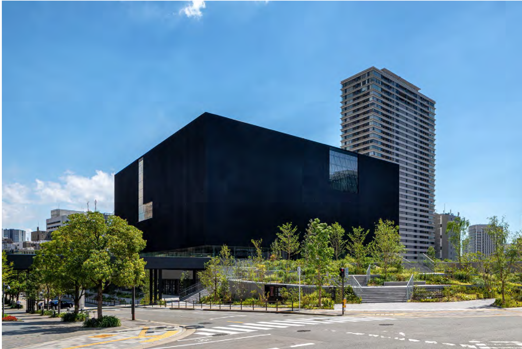
田蓑橋南交差点から北東面外観
