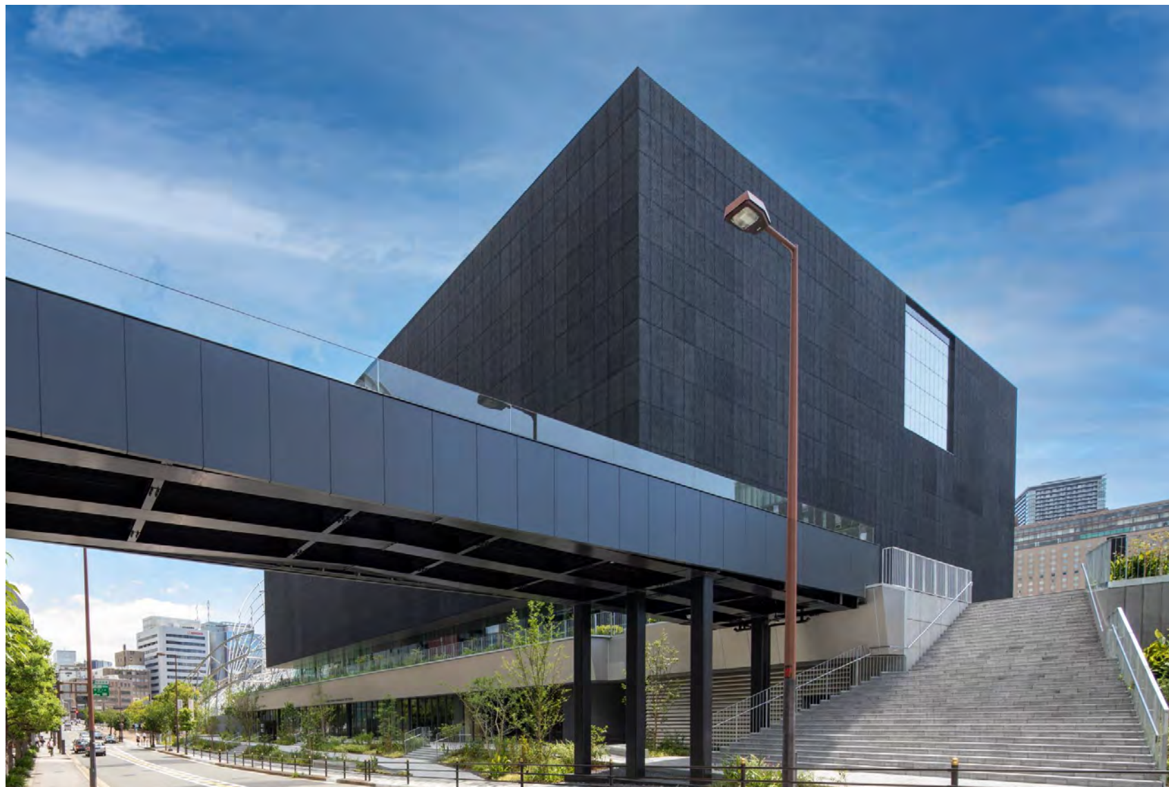
東面デッキ通路
