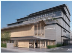
京都市:西京区総合庁舎
