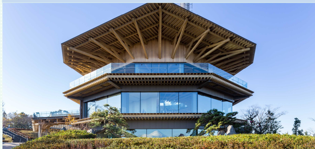
日本平夢テラス (H30.9月完成)
