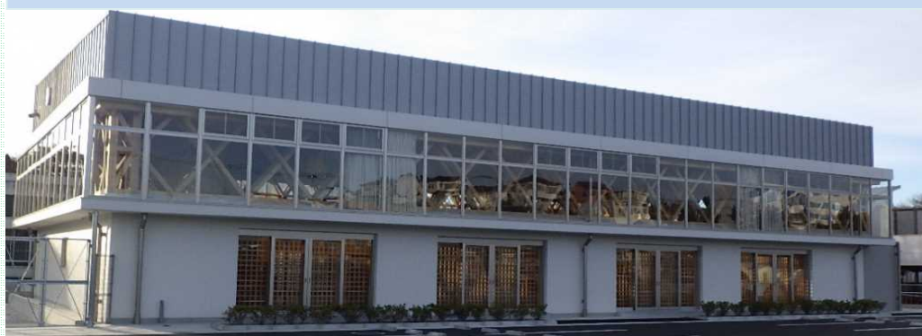
磐田学園機能訓練棟 (R5.2月完成)
