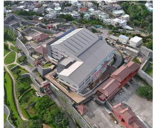
首里城正殿工事現場（素屋根、木材倉庫・原寸場設置）の状況
