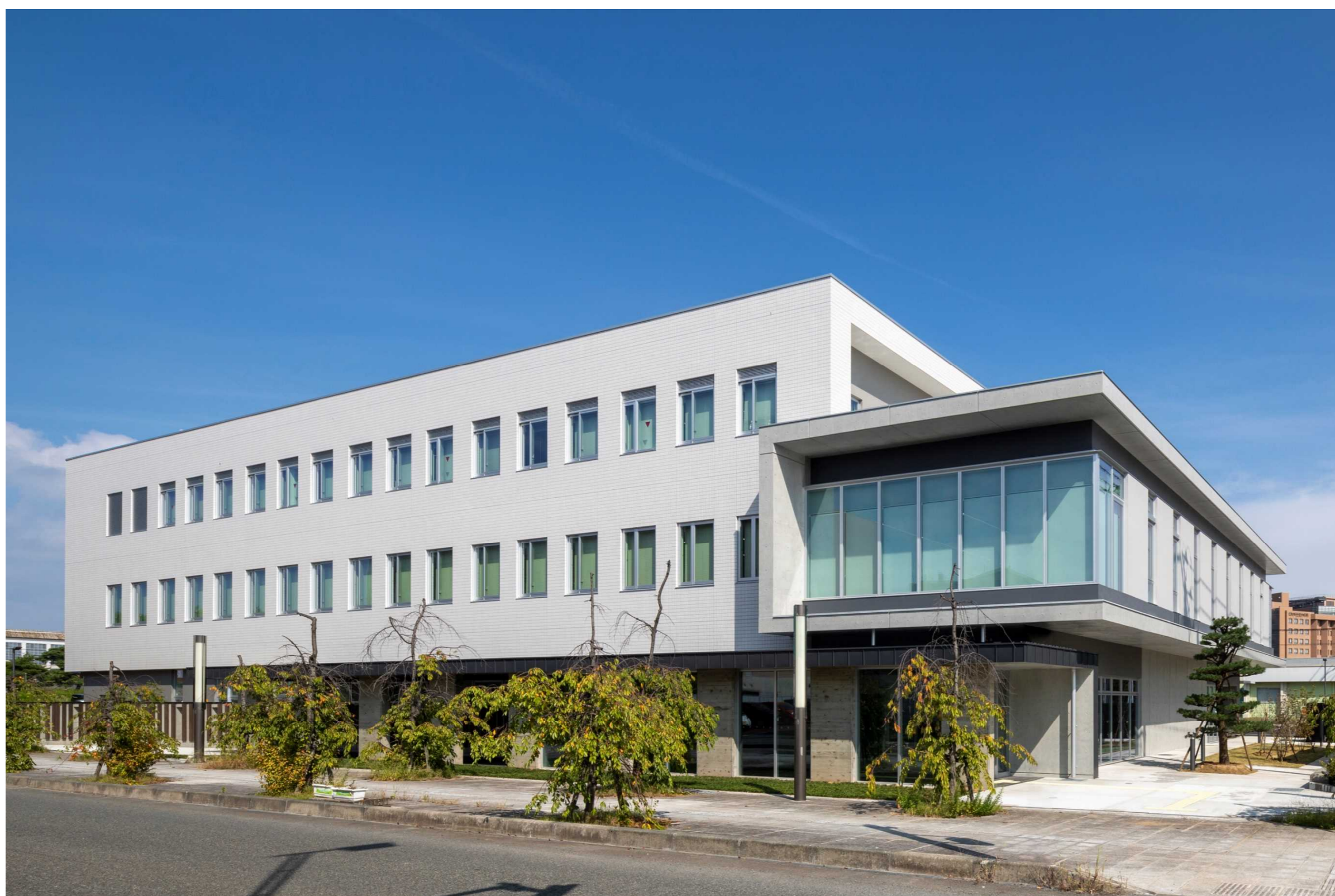
[庁舎南側外観]
