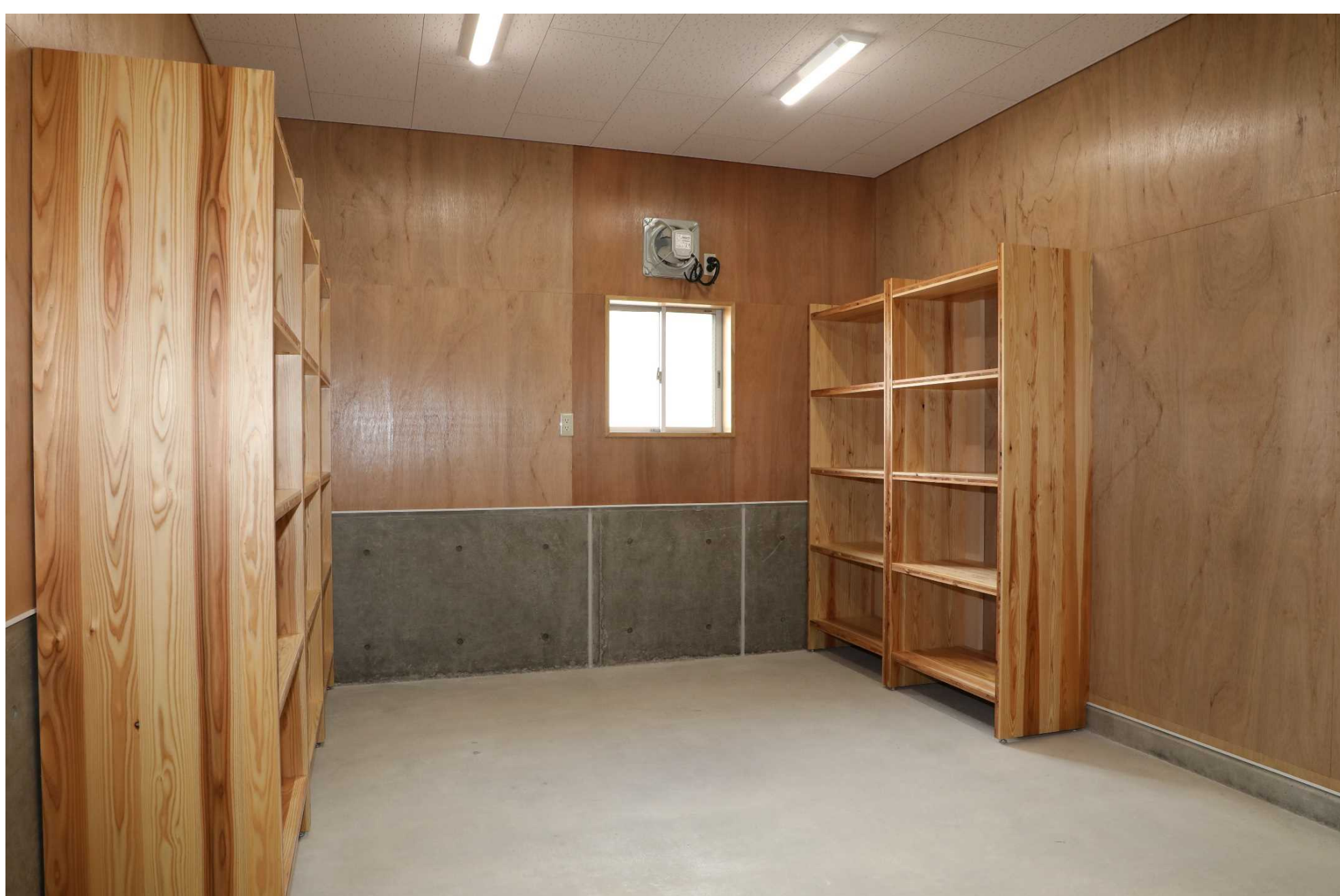
〔CLT材を使用した倉庫棚〕
