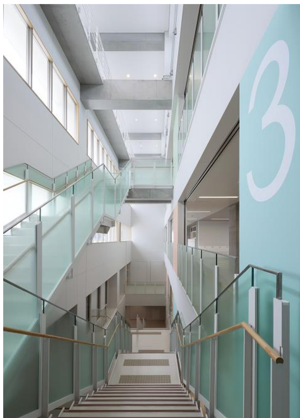
【階段吹き抜け】
