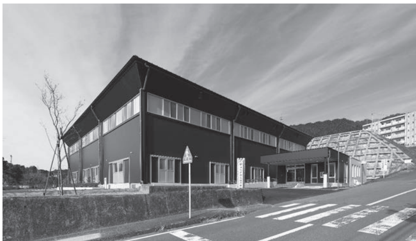
外観 (南東面)。コルゲート銅板からガルバリウム鋼板へ外壁改修し、イメージを一新
