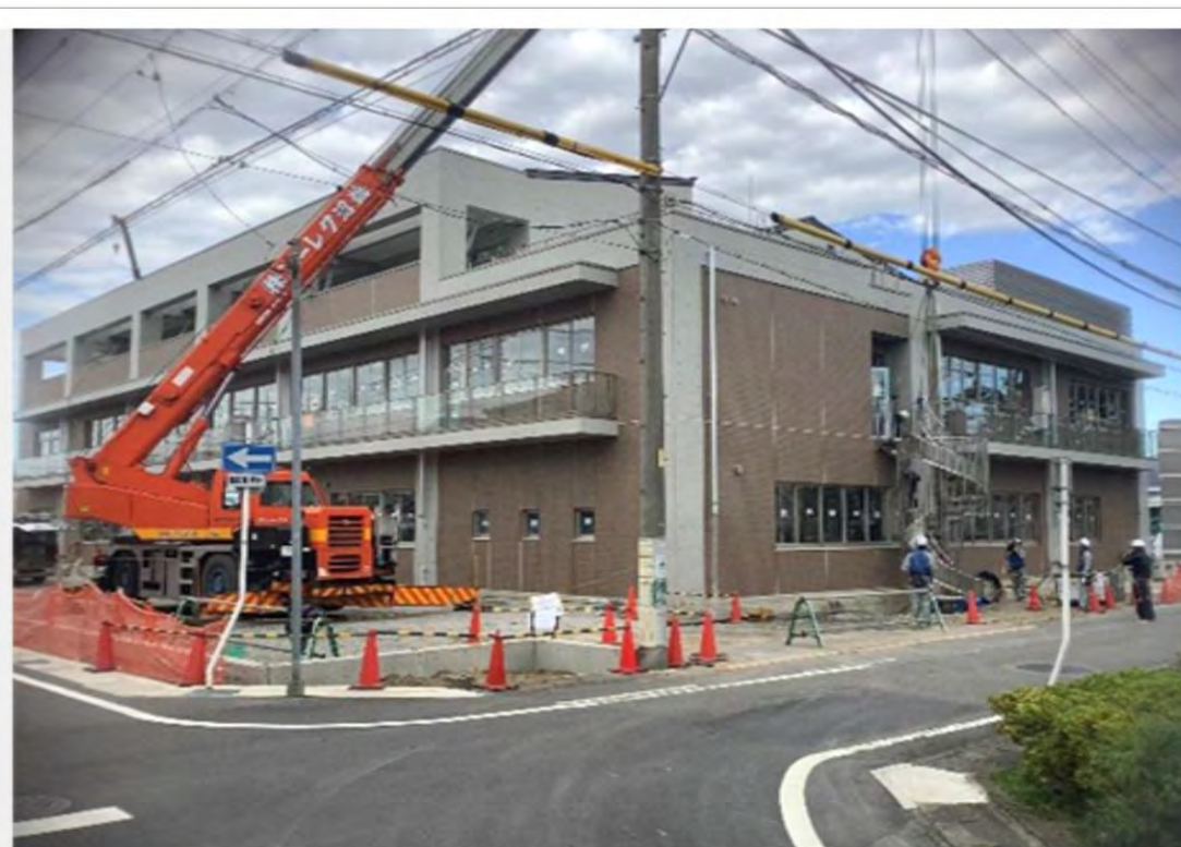
実際の施工状況
