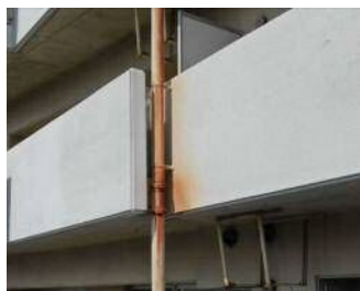
高所の劣化状況の調査
