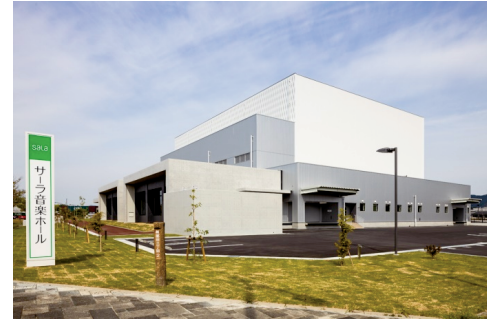
音楽ホール(南より)
