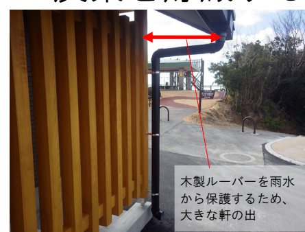
木製（杉）ルーバー外観
