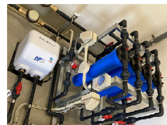
雨水浄化装置
