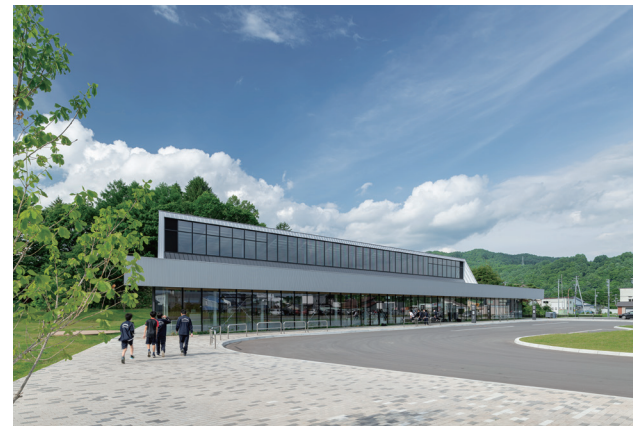
南側正面全景。中高生の通学路となる伸びやかなアプローチ。背後には鎮守の森の木々が鬱蒼と茂る
