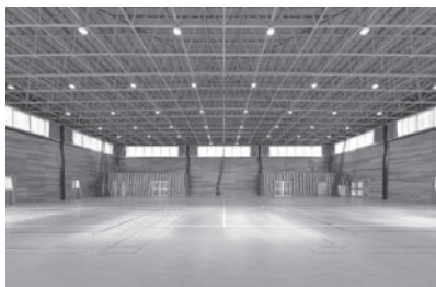
内観(体育館)。天井面トラスの再塗装や床、壁等を全面的に改修
