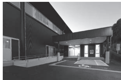
外観(ピロティ夜景)。UD 化に配慮し、エントランス付近に身障者専用駐車場を新設
