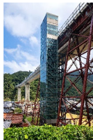
余部クリスタルタワー
