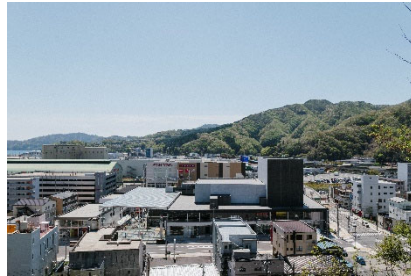
釜石市民ホール
