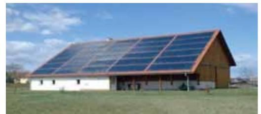
図 3-3 ウルパースドルフ村の夏期用太陽熱併設設備
