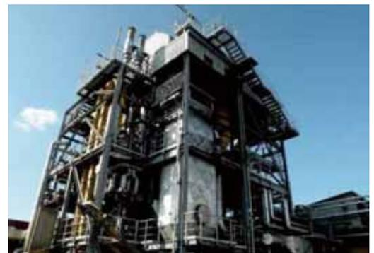
図 3-4 木質ガス化装置
