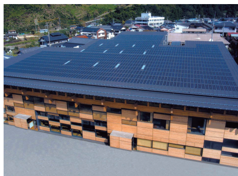
屋根太陽光パネル
