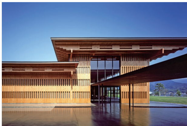
展示棟エントランスを見る
