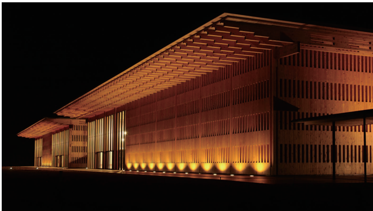
北側全景 (夜景)
