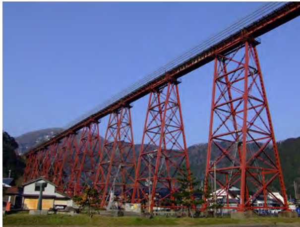
余部鉄橋 （近代土木遺産）
