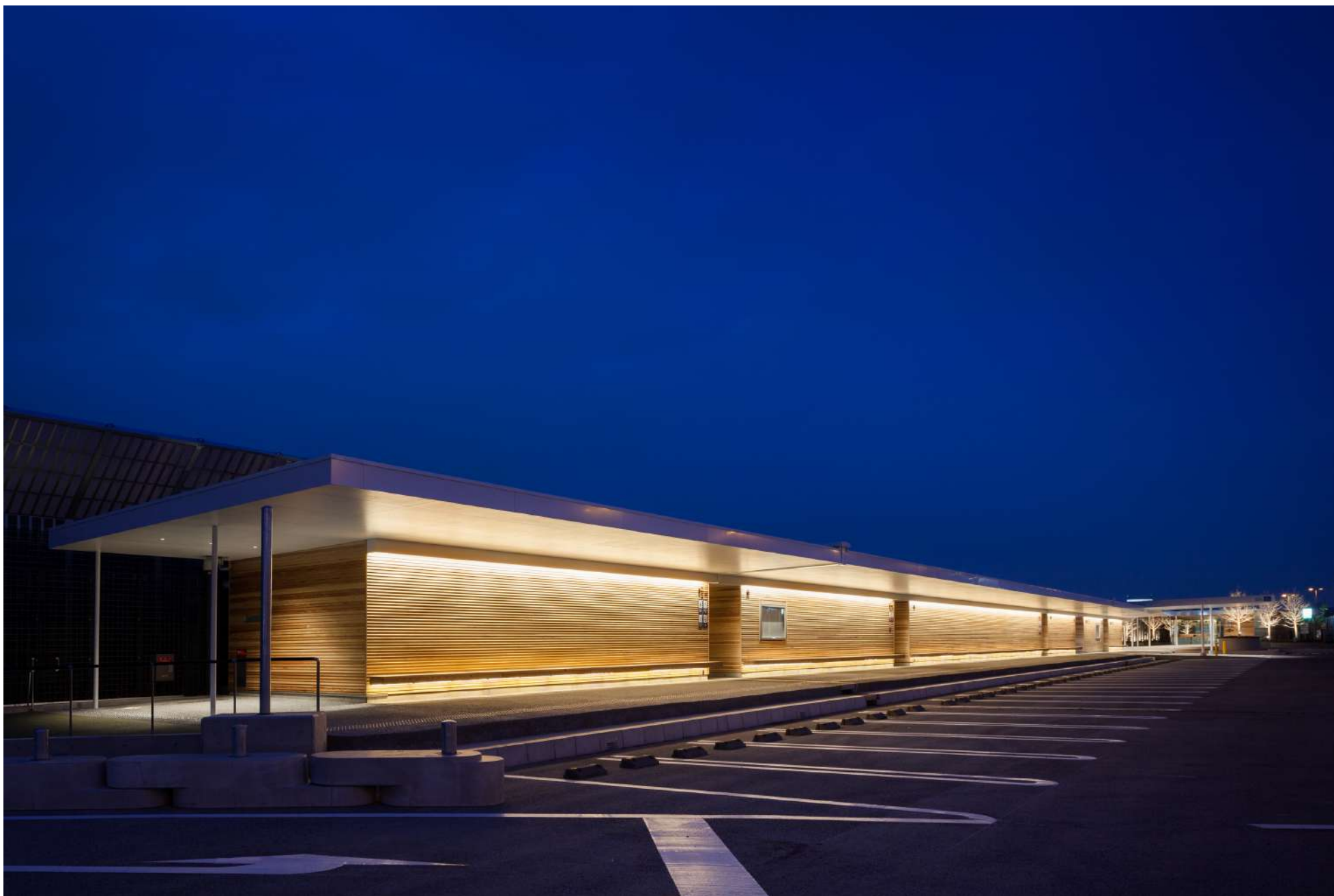
160mの長い建築は、夜でも高速道路から視認性の高いサービスエリアとなっています。
