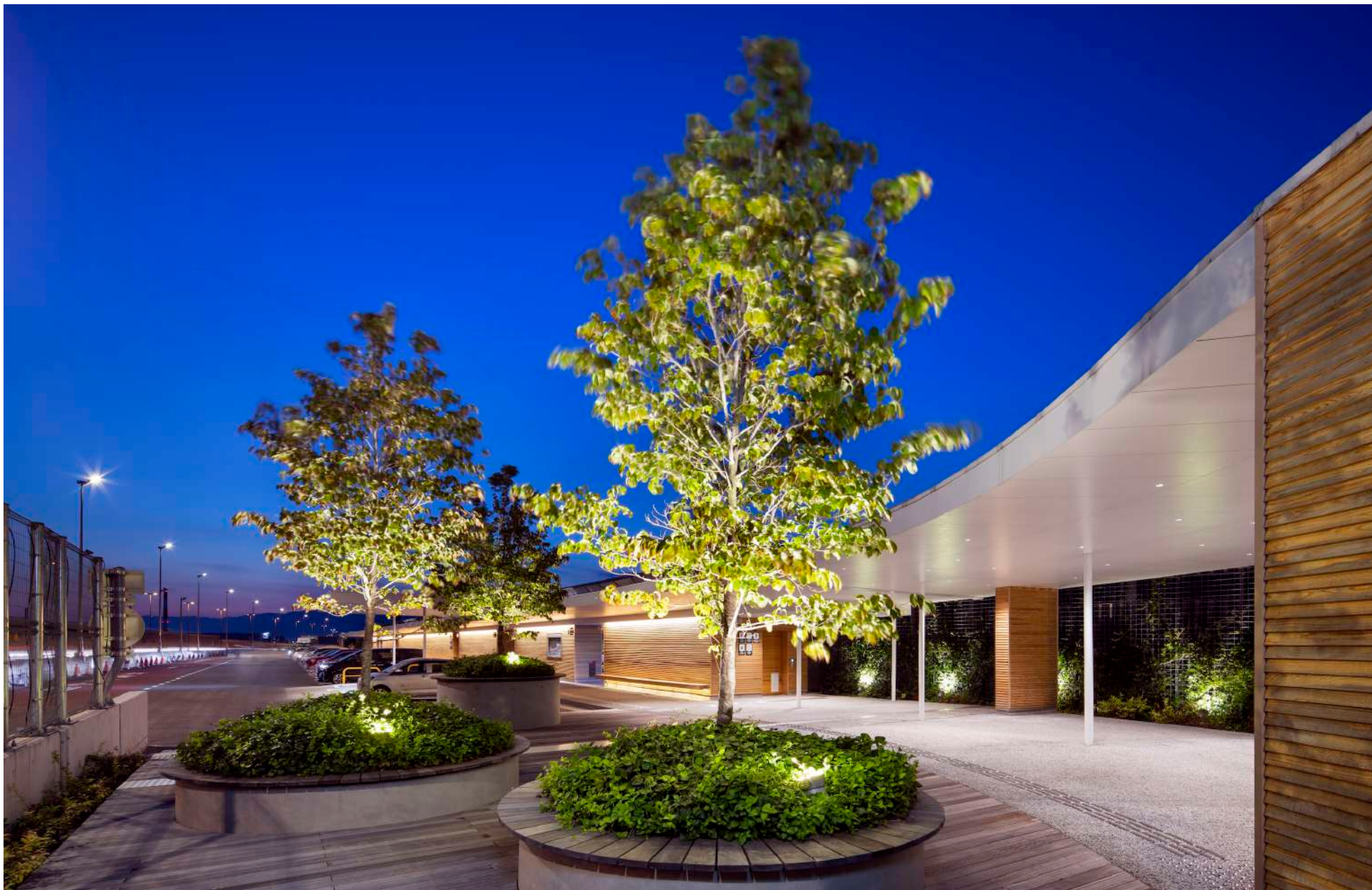
夜でも高速道路からライトアップされた木々が見え、高架上に公園のような緑が溢れます。
