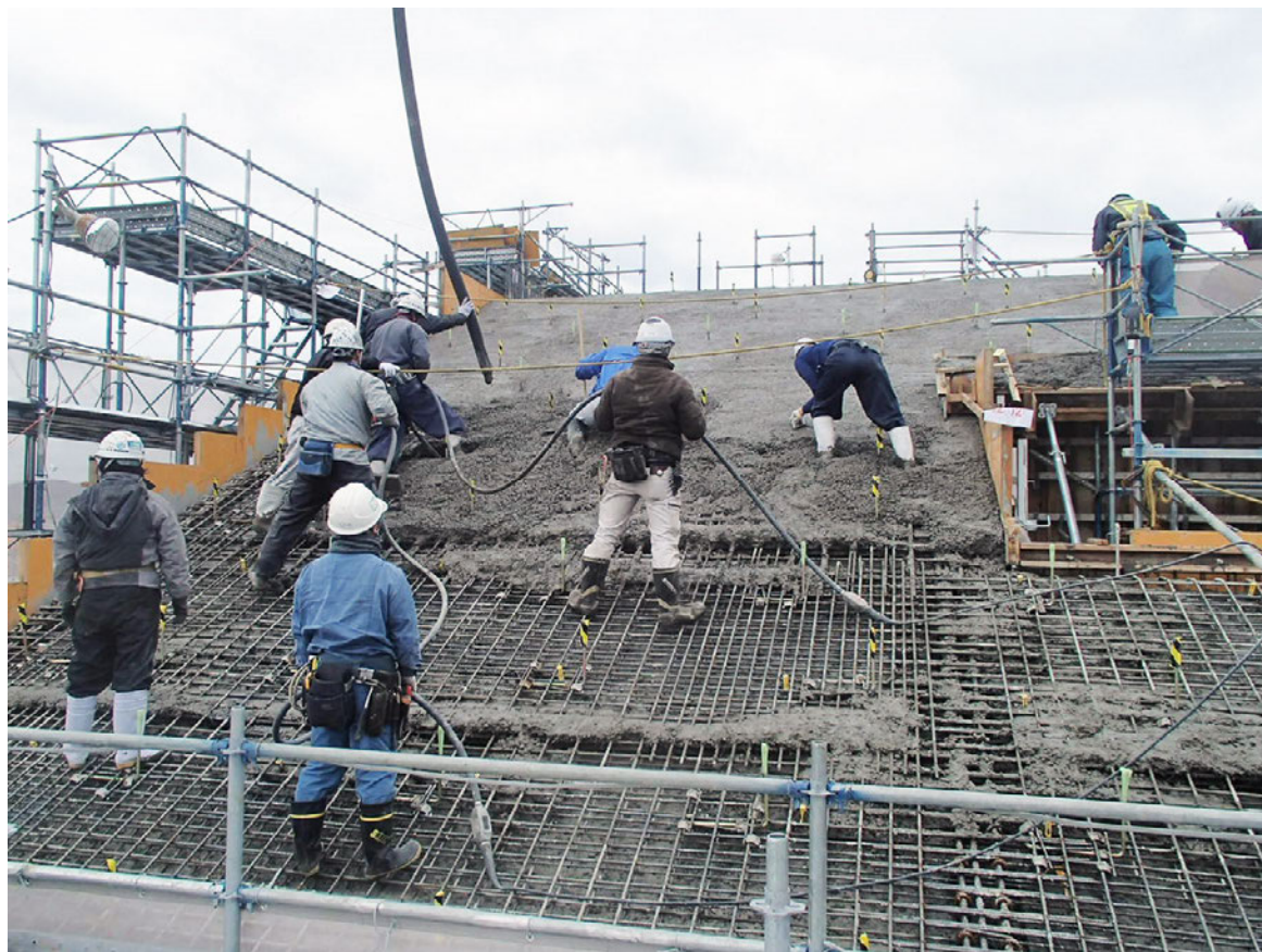
勾配スラブのコンクリート打設
