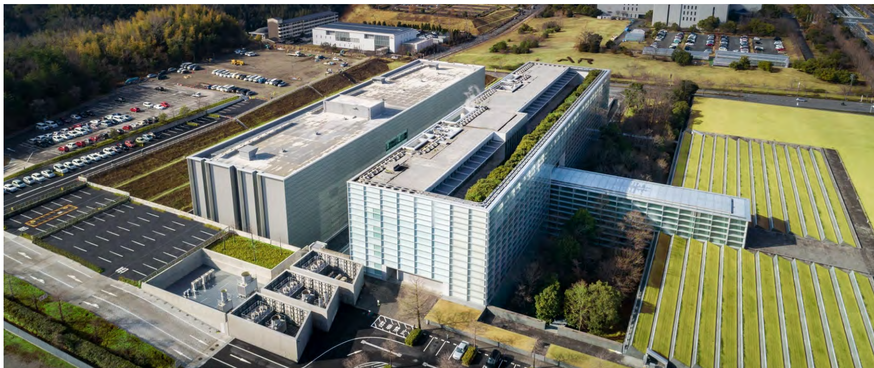
完成写真（既存本館・書庫の関係性）
