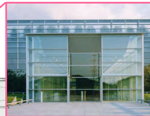
既存本館 正面
