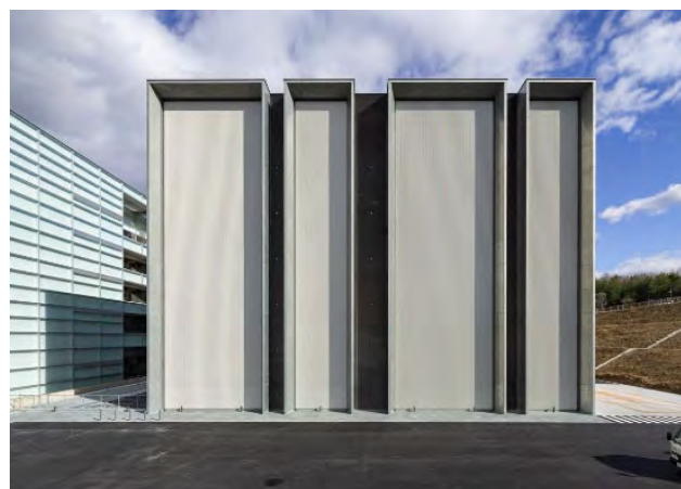
西面外観(日中)
