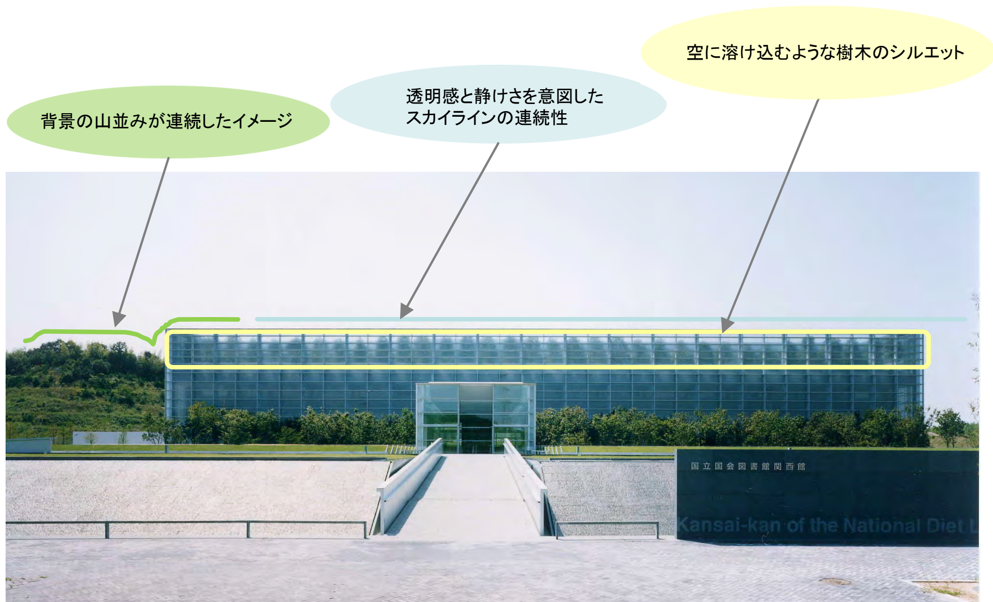
既存本館 正面
