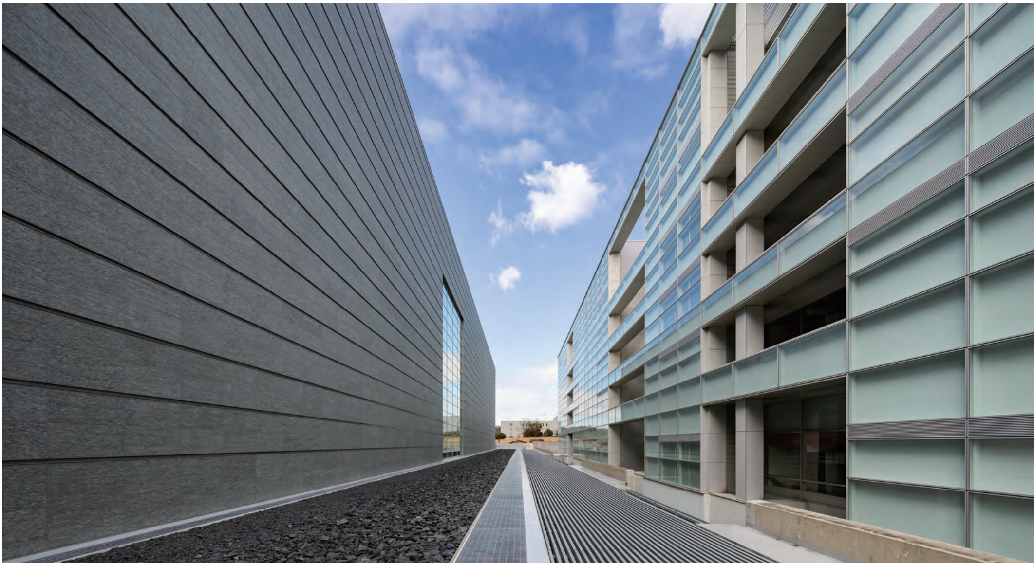
■ 本館と書庫棟間を東側からの外観写真
