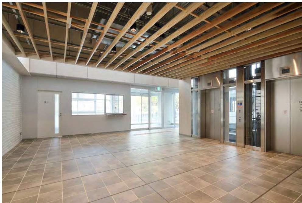
天井木製ルーバー
