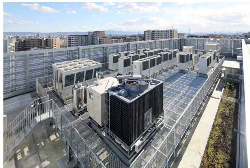
自家発電設備
