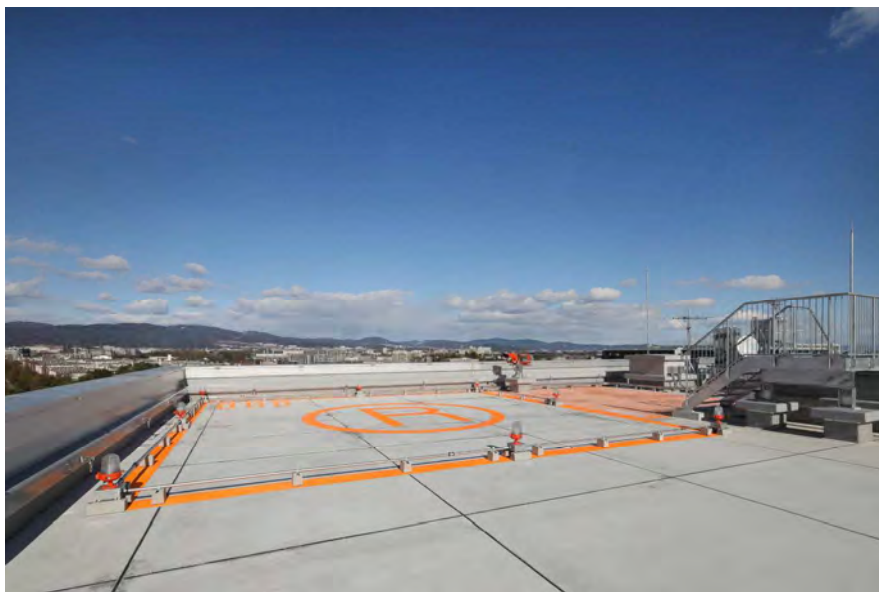
屋上ヘリポート
