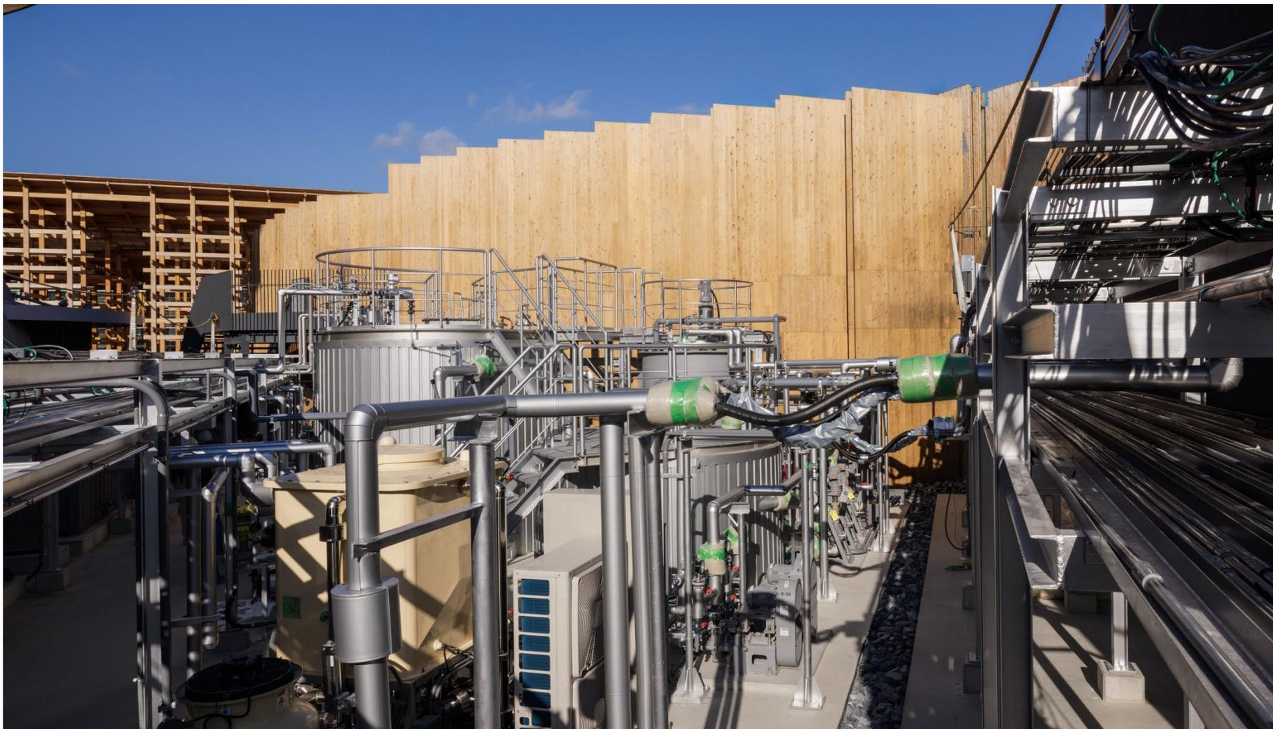
いのちの循環を象徴的に表わす展示の一つとして、バイオガスプラントが実装されている。万博会場では生ごみを回収し、微生物の働きで発酵分解することで発生するバイオガスを用いてパビリオン敷地内で発電している。
