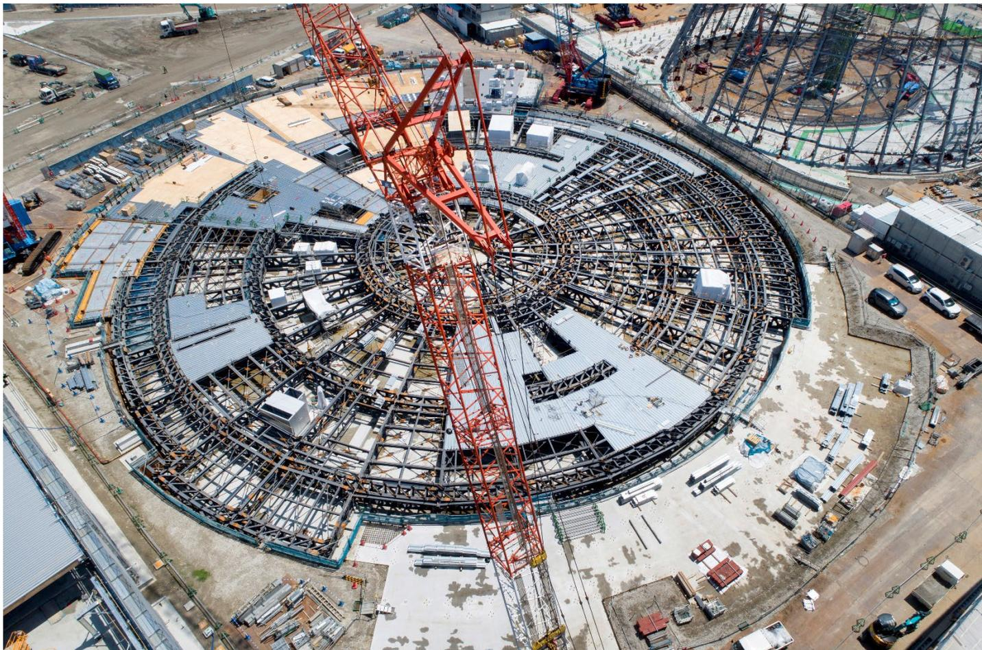
本敷地は広大な埋立地に位置しており、主として粘性土層の圧密沈下への対応が必要となった。そこで、地盤面より約2.5mを掘削し、排土重量と建物重量とのバランスを確保した直接基礎（排土バランス基礎）を採用した。さらに、柱軸力が不均一になった場合の局所沈下へも対応できるように、剛強で変形追従性能が高い鉄骨トラス基礎梁により柱軸力を分散させることで、沈下差の平準化を図る計画とした。
