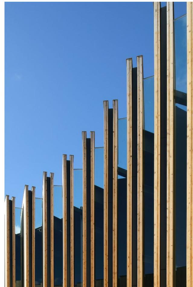
円環状に立ち並ぶ大判のCLTの構成を極力シンプルに表現するため、ガラスをCLTにサッシレスで嵌め込むことに挑戦した。まず、ガラス枠となる壁ユニットにおける風による複雑な変形に対し、どのようにガラスがスライドやロッキングしながら変形するのか、精緻な図化による検証を行うことで、変形追従が可能であることを確認した。また、CLTは木材としての特性上、反りや収縮などの変形を免れ得ず、それに伴いCLTにガラスが接した際のガラスの応力集中について、FEM解析を行い、ガラスが破損しないこと、むしろ、ガラスがCLTの変形を抑える役割を果たすことを確認している。CLTに直接ガラスを嵌め込むために使用するシーリング材の選定に際しては、同様の実例がなかったため、接着力試験と防汚試験を実施しシリル化アクリレート系シーリングを採用した。
