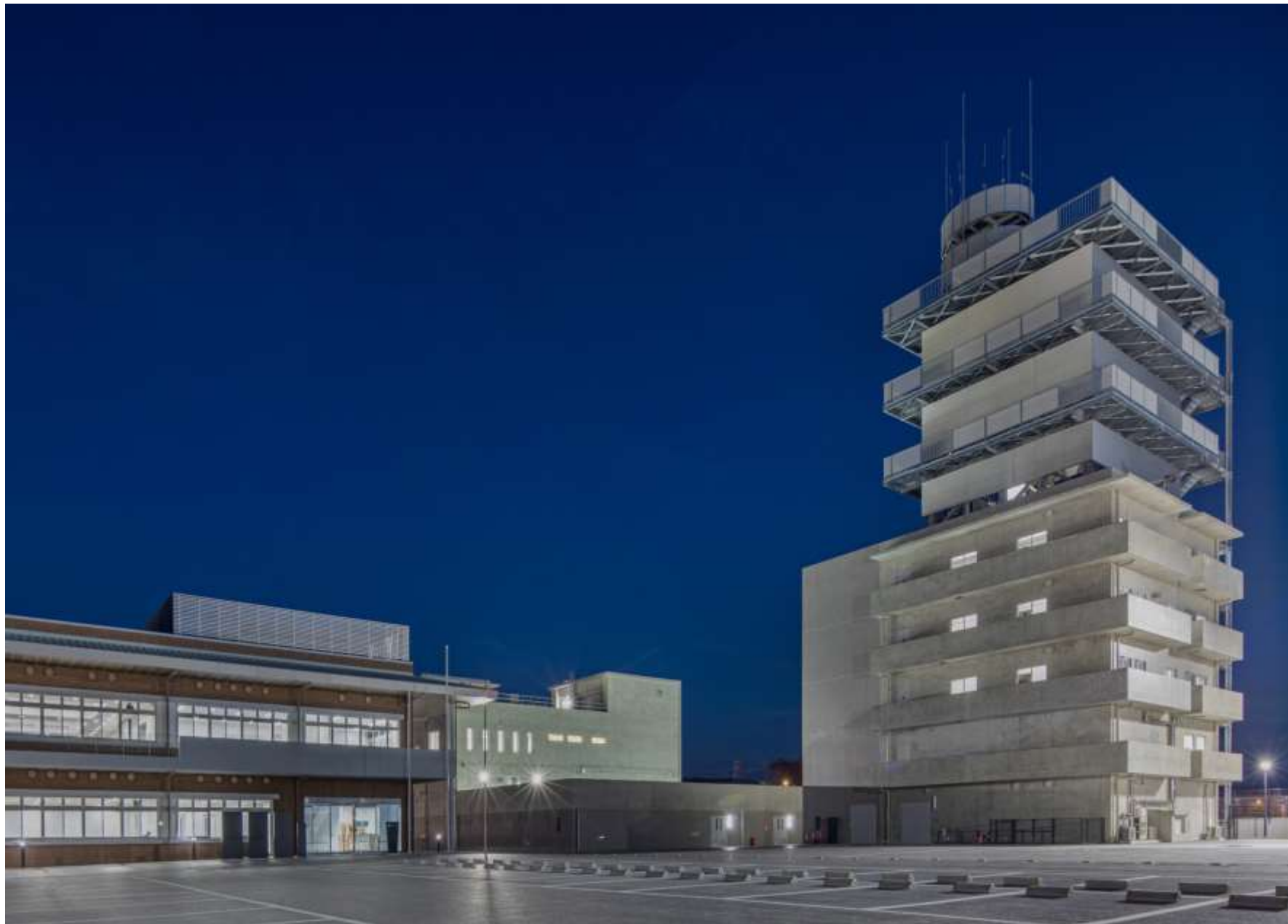
総合訓練棟(全景)
