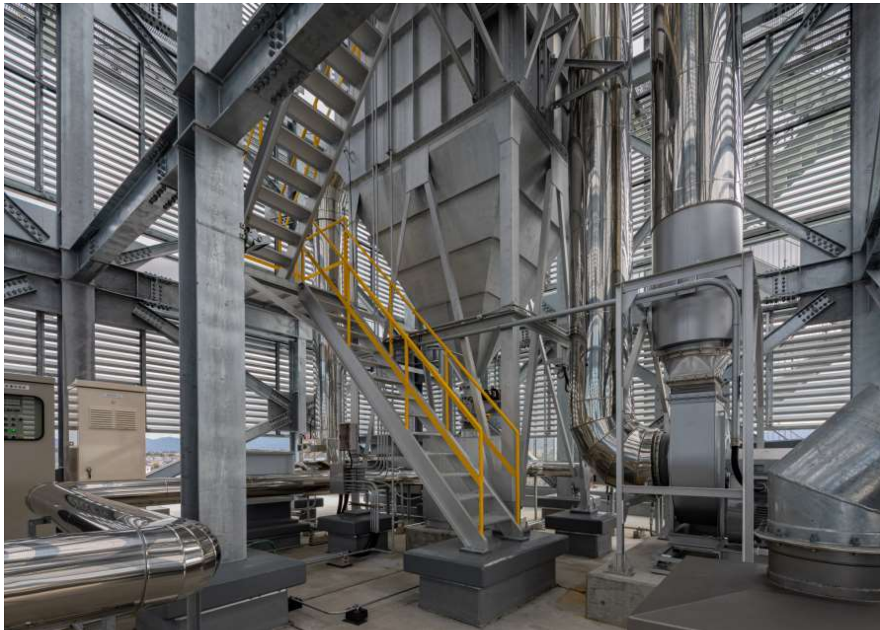
排煙處理設備
