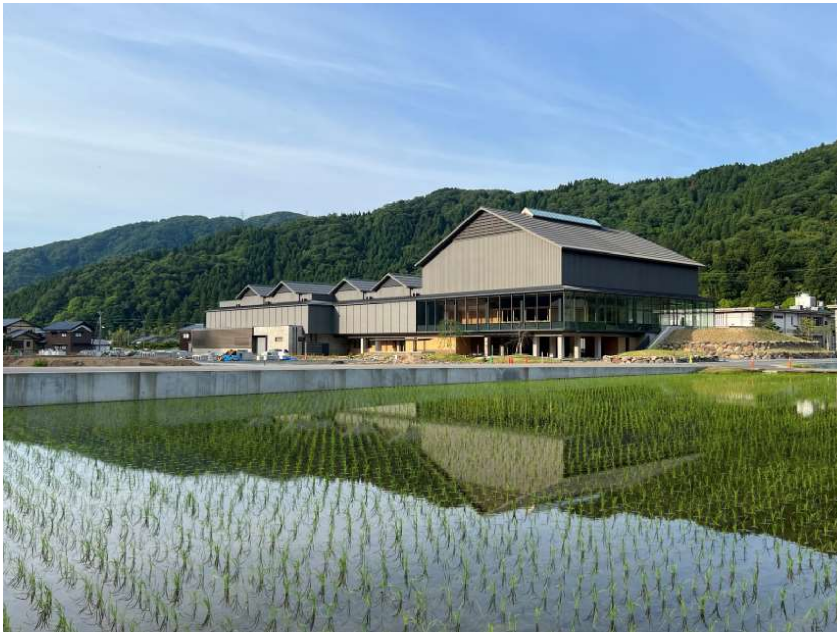
山並みの風景に呼応する連続切妻屋根の外観
