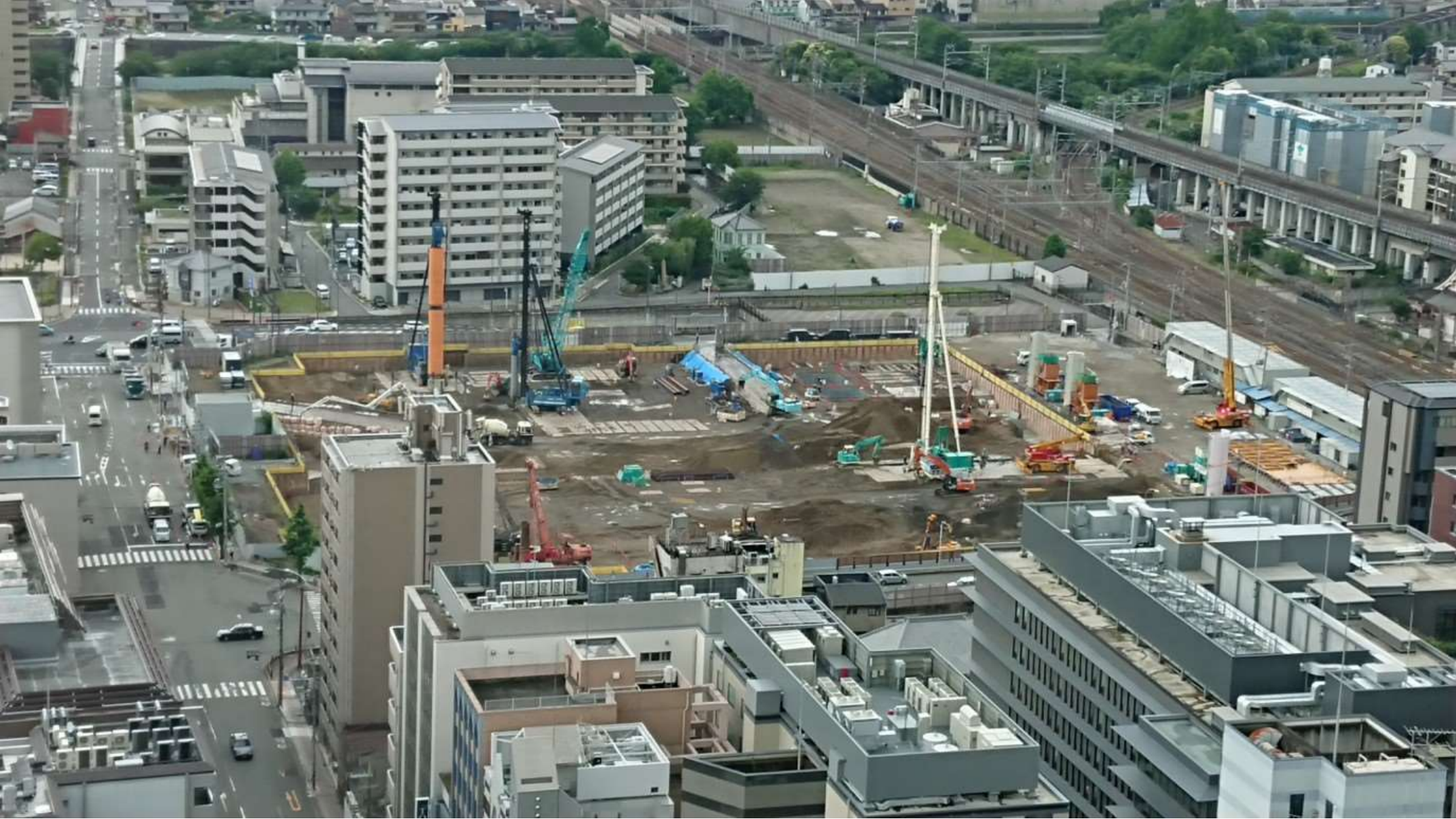
工事写真：令和3年6月時点
