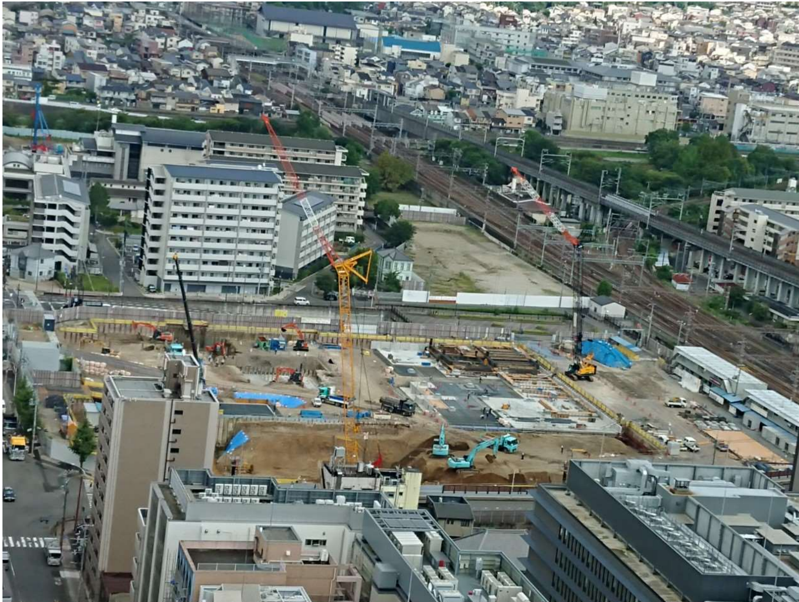
工事写真：令和3年8月時点
