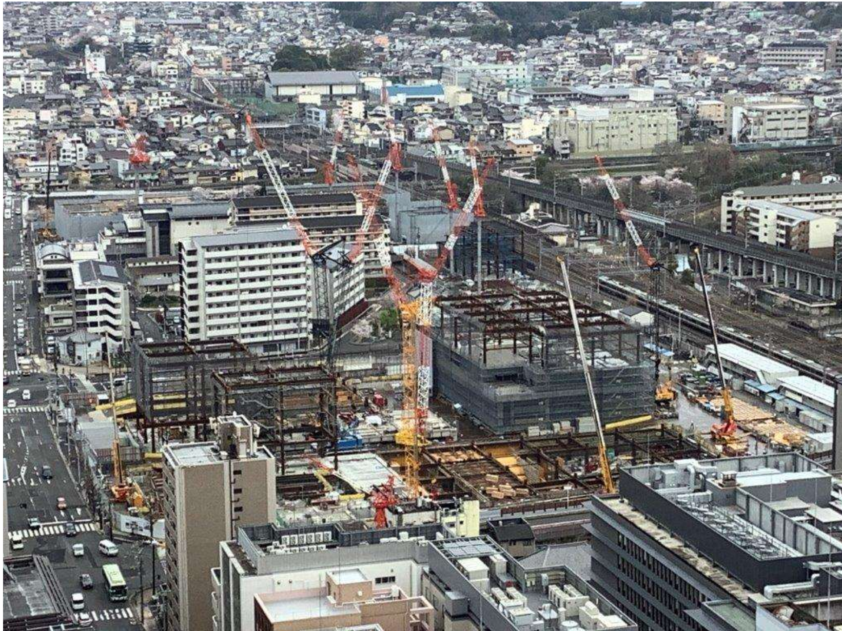
工事写真：令和4年3月時点
