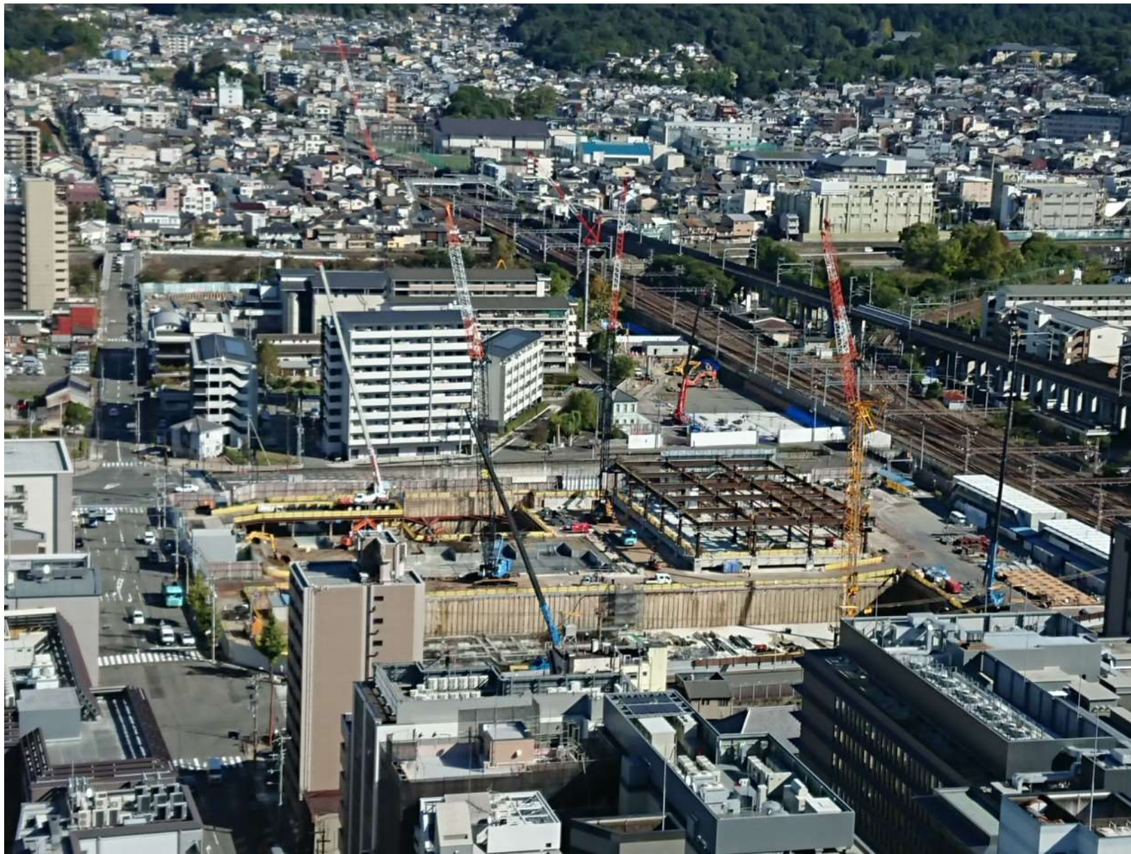
工事写真：令和3年10月時点
