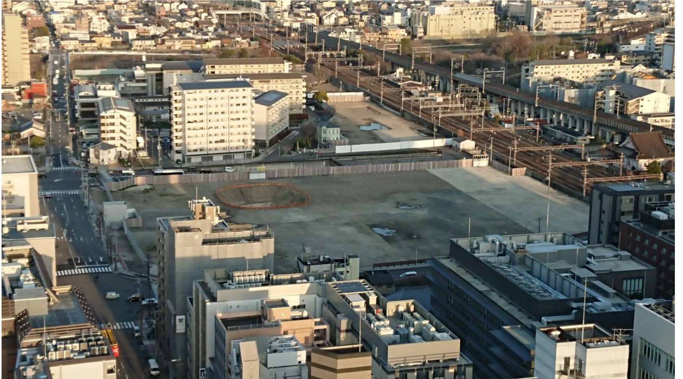
工事写真：令和3年3月時点
