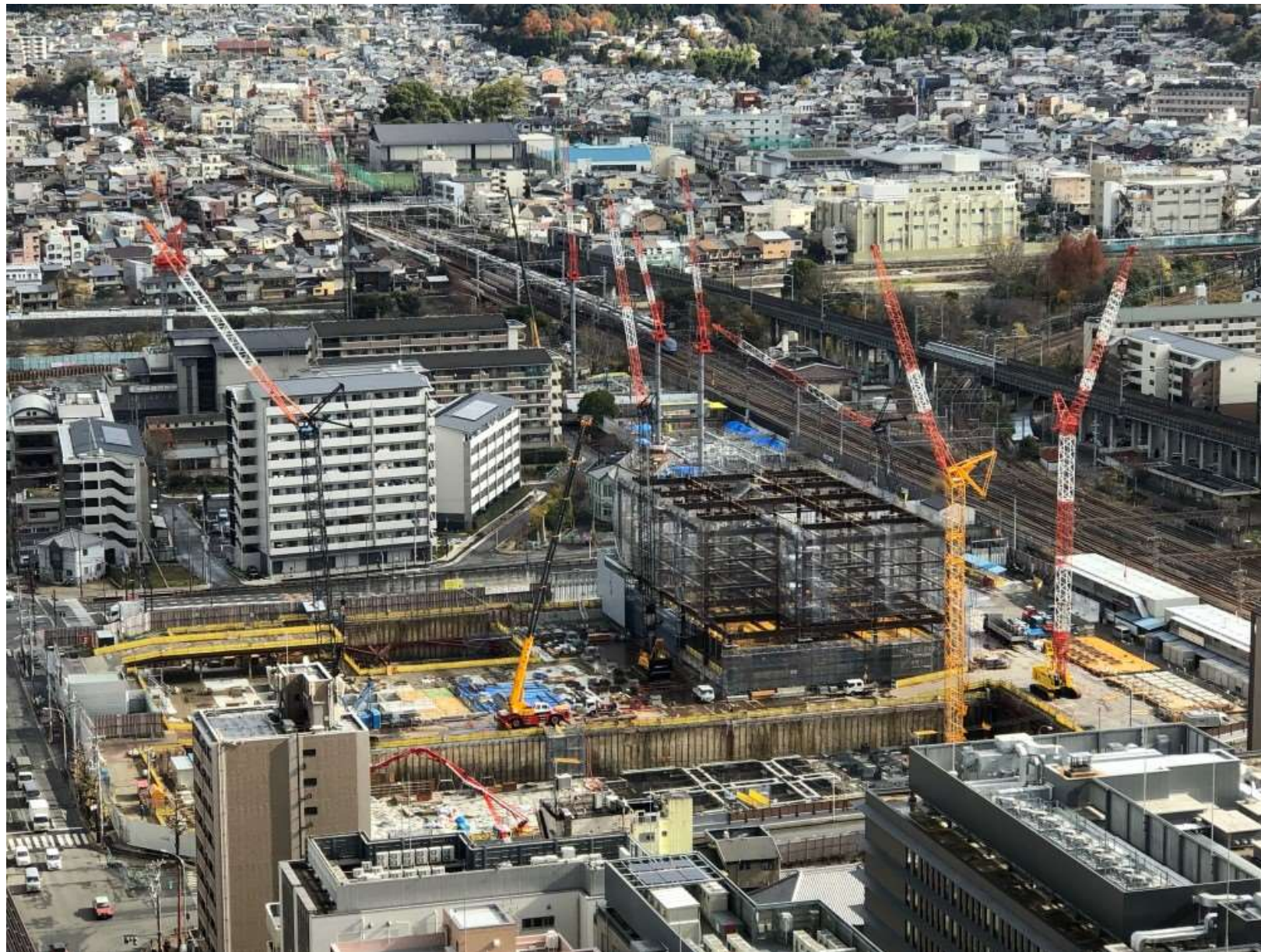
工事写真：令和3年12月時点
