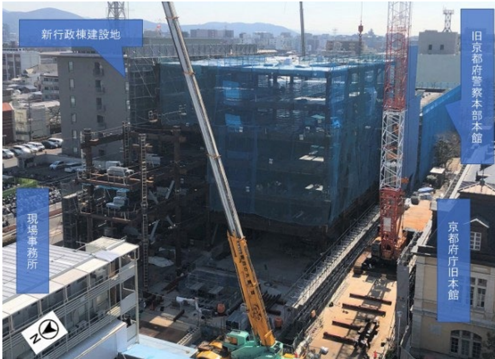
3-1工区（新行政棟北東側）1~6階の鉄骨建方（令和4年2月28日撮影）
