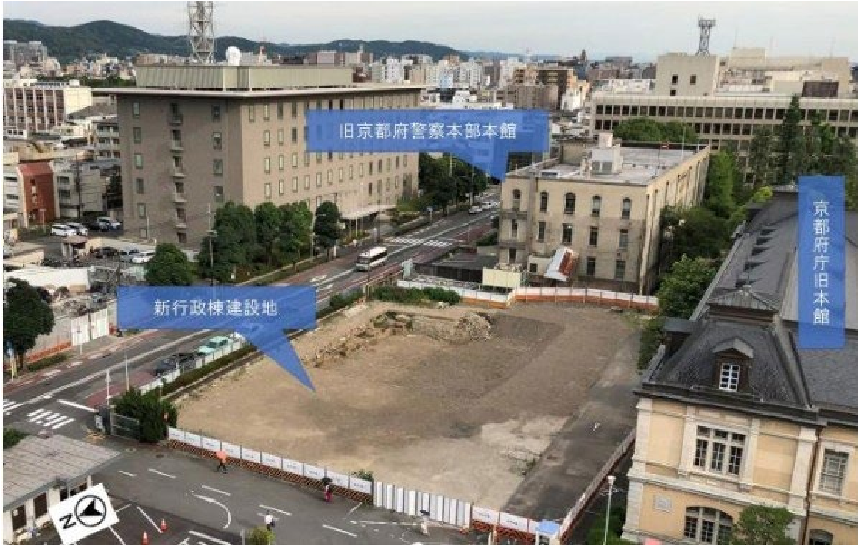
工事前の状況（令和2年6月17日撮影）
