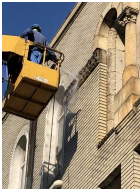
上部の窓周辺、装飾部分の洗浄テストの様子です。
