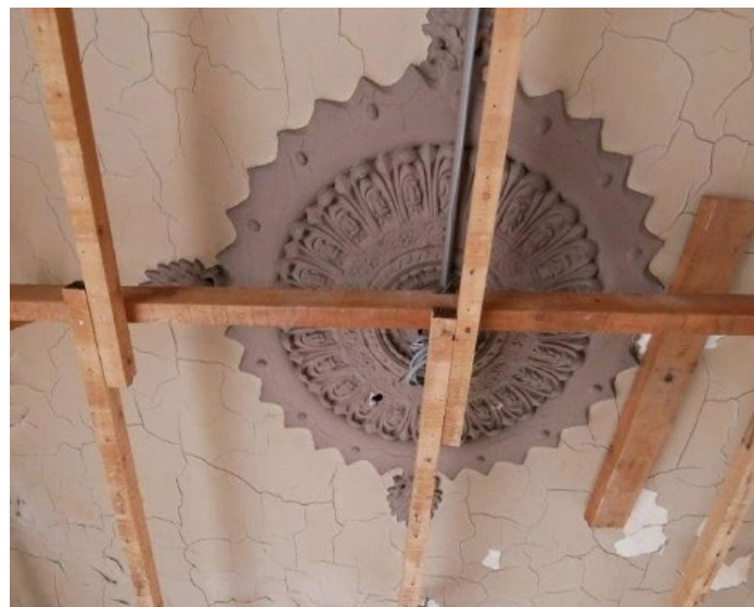
今回現れた天井中心飾り
