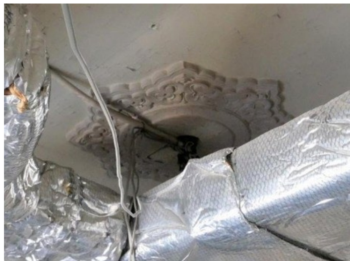
今回現れた天井中心飾り
