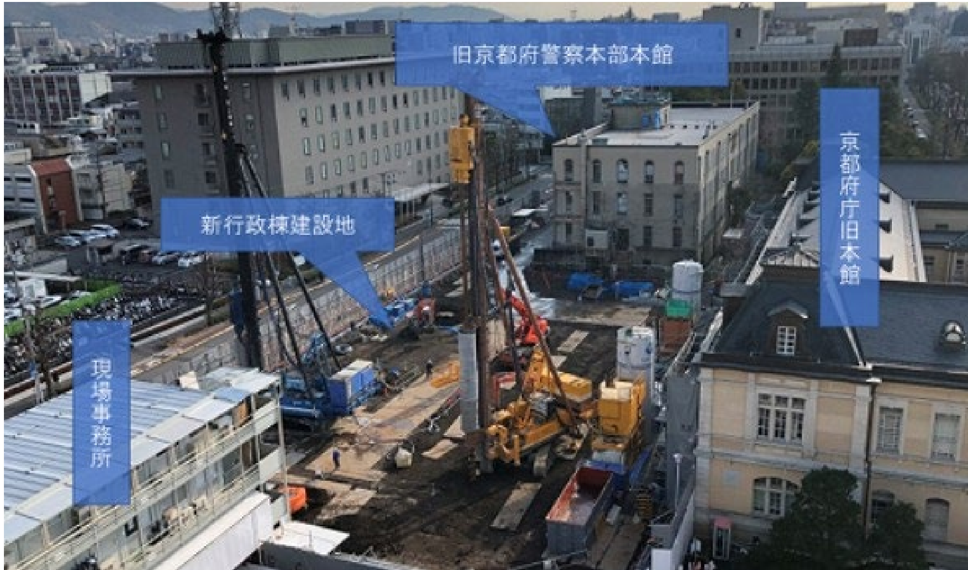
山留め工事（令和3年1月13日撮影）
