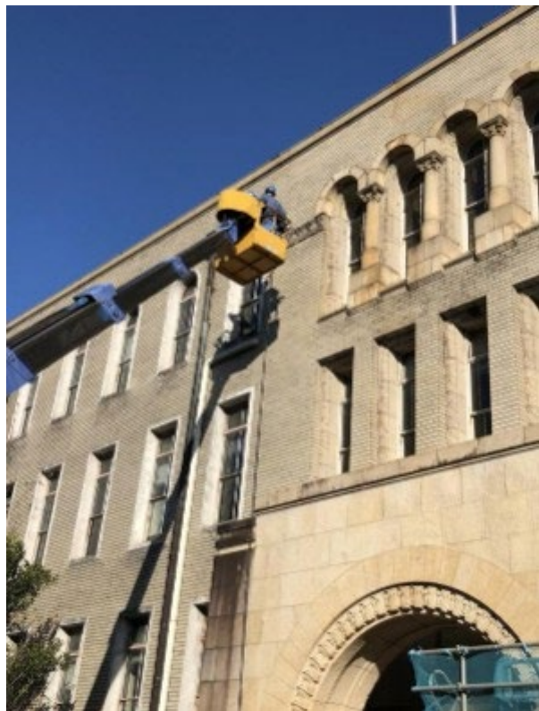
建物西側にて、洗浄テストを行いました。
