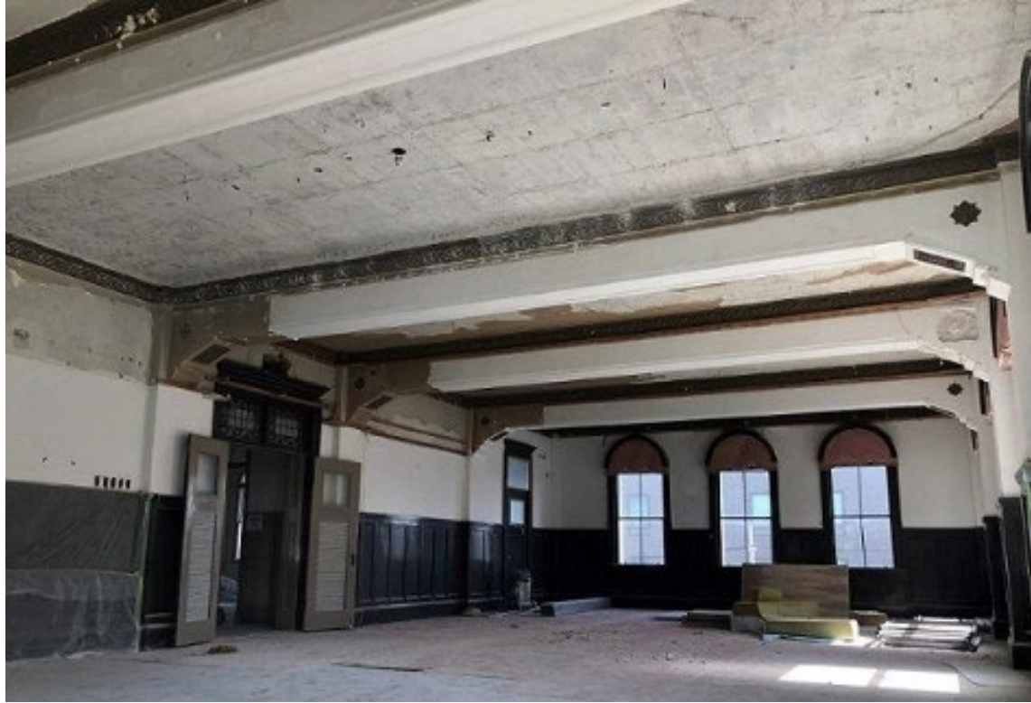
内装撤去後の様子
