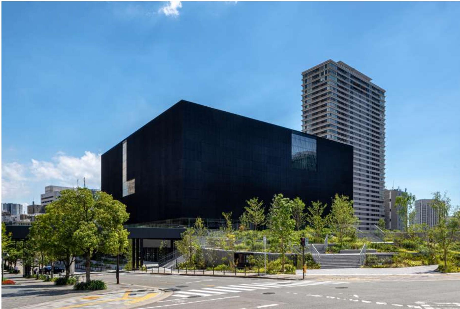
田蓑橋南交差点から北東面外観
