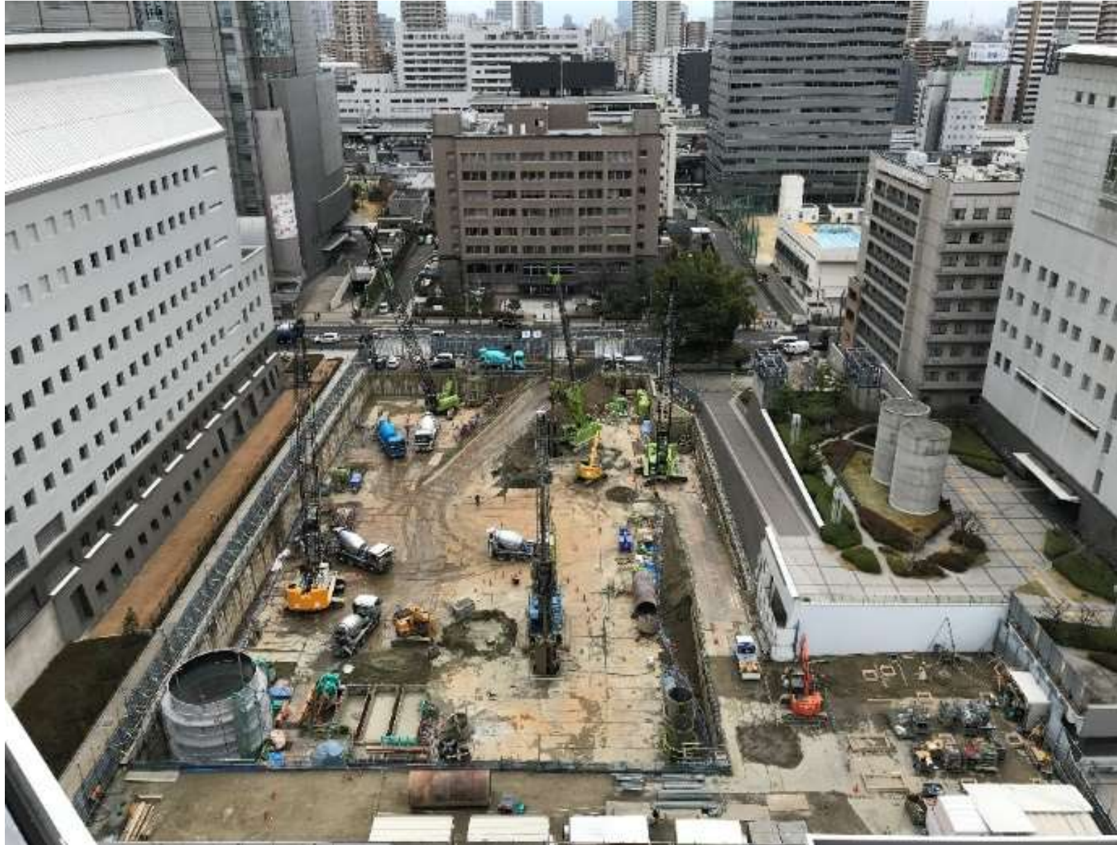
工事写真：令和2年1月時点
