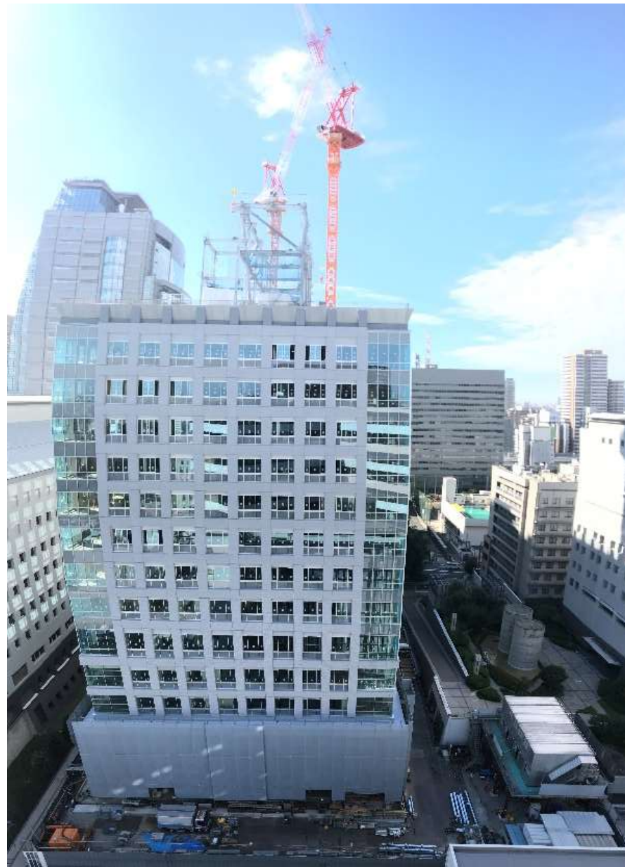
工事写真：令和3年9月時点
