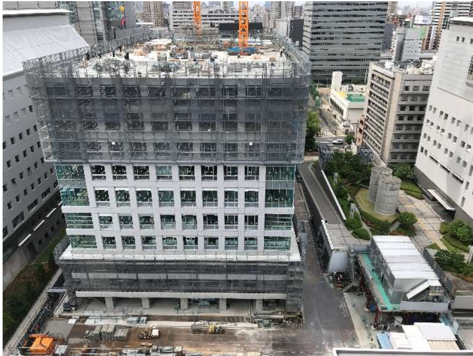
工事写真：令和3年5月時点
