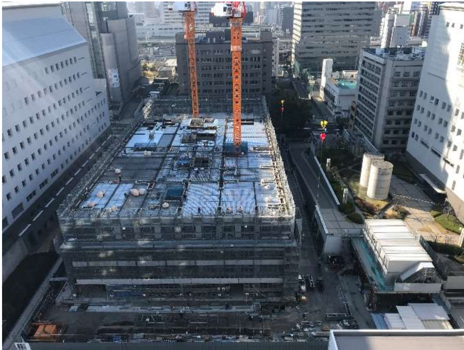
工事写真：令和3年2月時点
