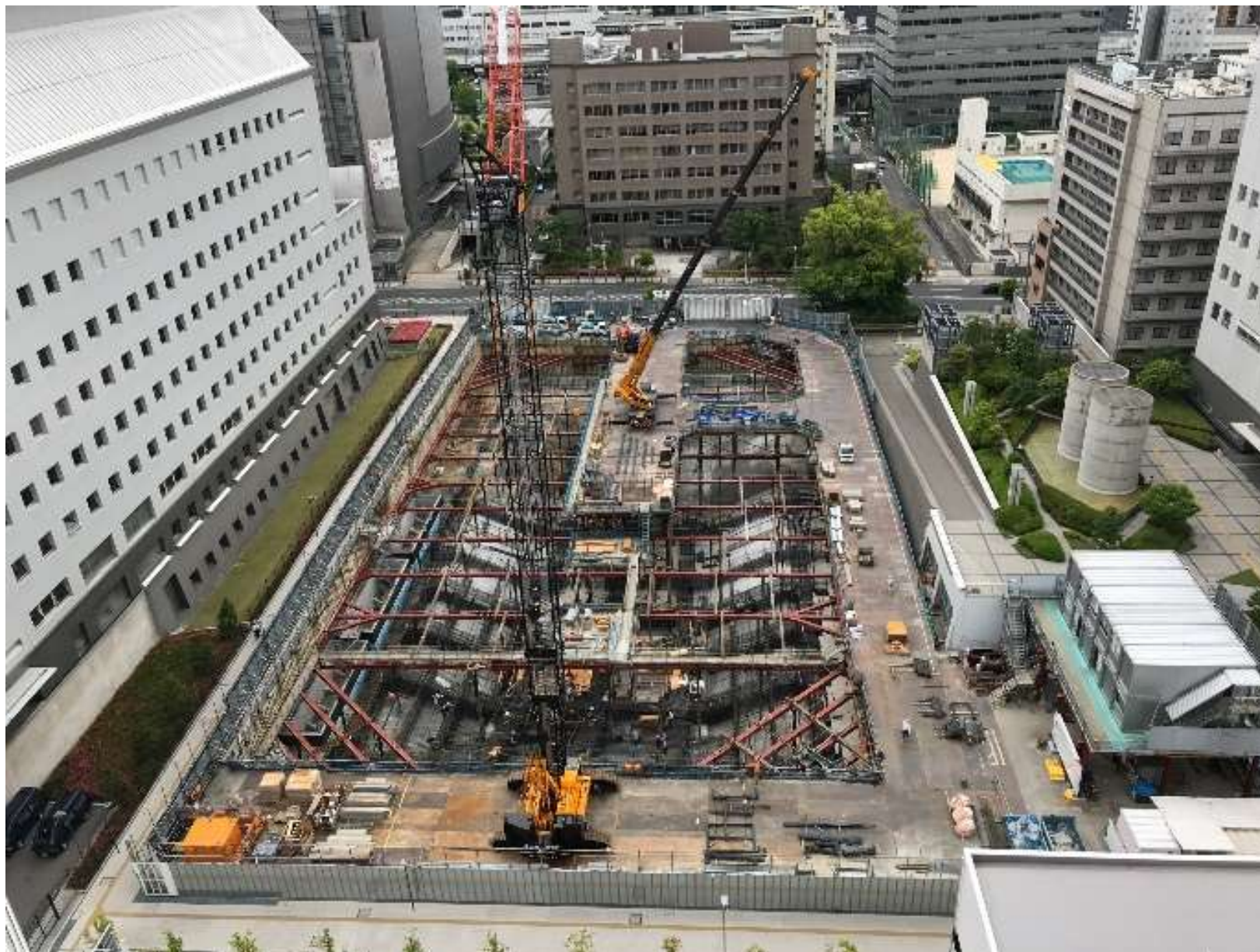
工事写真：令和2年5月時点
