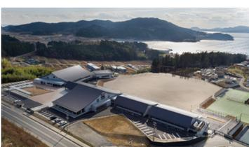
東日本大震災で受けた被害を踏まえ、広田湾に臨む傾斜地に建つ校舎は、1階でも2階でもどこにいても直接外へ出られる設計になっている。2階の玄関からは山側にある駐車、駐輪場へ、1階は校舎から海側の広々としたグラウンドへ出られる。振り向けば校舎の大屋根が美しい。柔らかい特性を持つ県産材の気仙杉を、船の造作加工を得意とする気仙大工が腕を振るって流れるような大屋根に張り上げ、いぶし銀の光沢をもつ柔軟なガルバリウムで瓦のような趣を出している。内装は岩手県産のカラマツ。内部空間はシームレスに連続し、将来のさらなる少子
